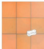
PASO 9: Se debe emboquillar una vez se haya secado el mortero o pego de la instalación.
