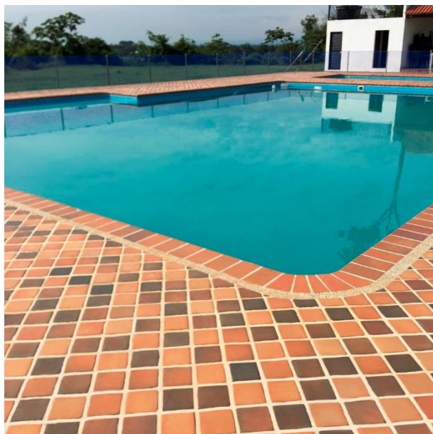
Instalación en exteriores / zonas sociales / piscina
